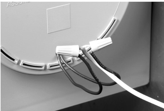
Fig. 49. Raccordement du moteur.
