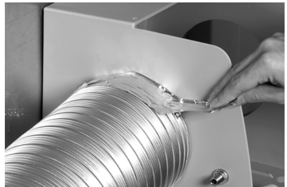
Fig. 15. Scellage des raccordements avec du ruban.
